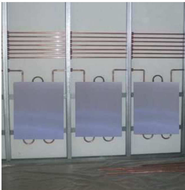
Bild: Verbindung mehrerer Elemente können von oben (w. Foto) oder unten angeschlossen werden.
